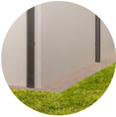
Pieds de murs en gravillons
